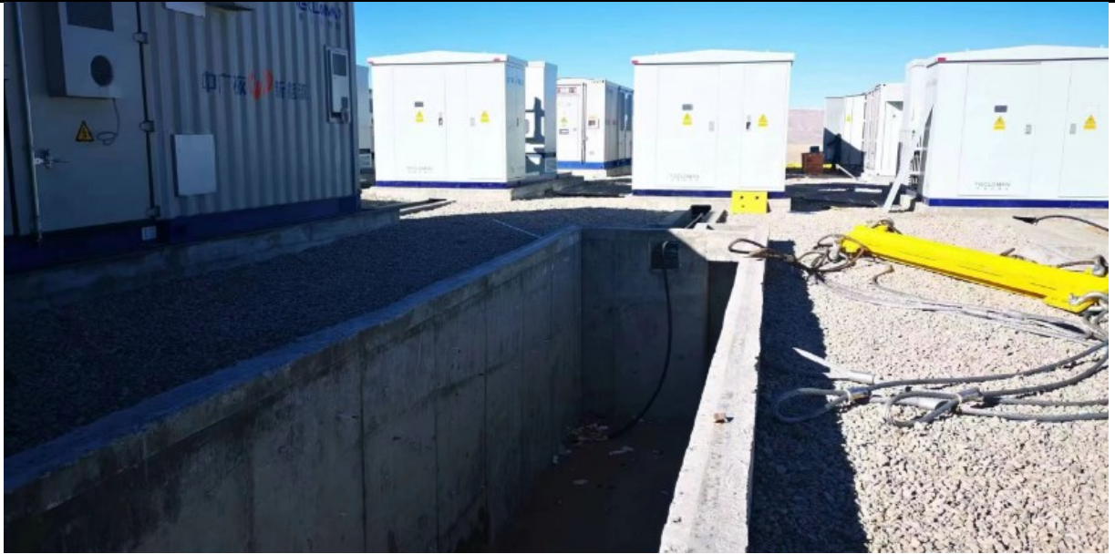
图 5.2-1 储能区电池舱底部基础坑
