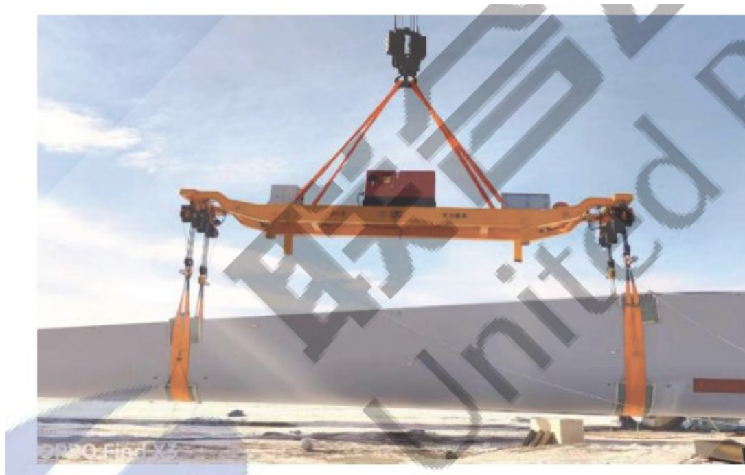
图 2.9-3 单叶片吊具示意图
