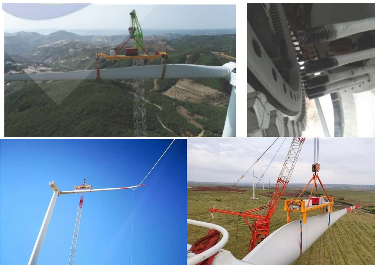
图 2.9-4 单叶片吊装组合
